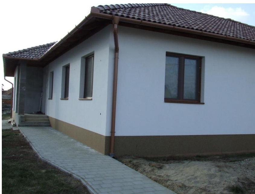
In augustus 2014, na een bouwtijd van 8 maanden is de woning opgeleverd
