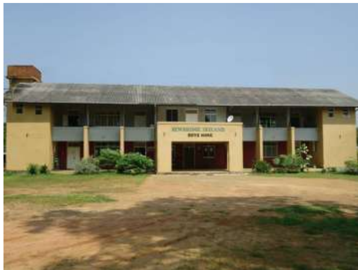
Het New Bridge kindertehuis in Nittambuwa
