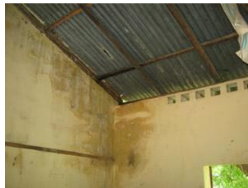
Gaten in de dakplaten, roest en schimmel langs de muren
