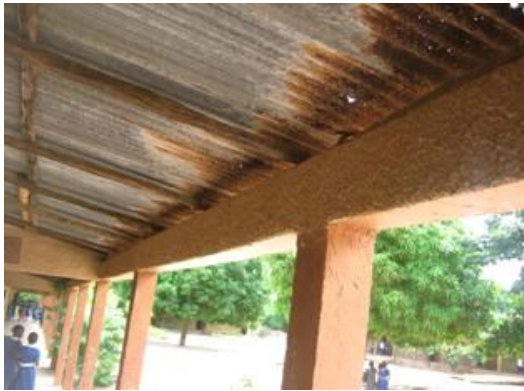
Gaten in de dakplaten, roest en schimmel langs de muren
