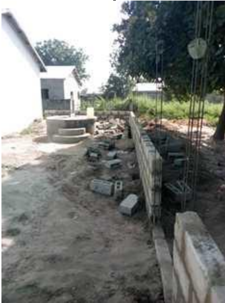
De bouw van het hekwerk is van start gegaan
