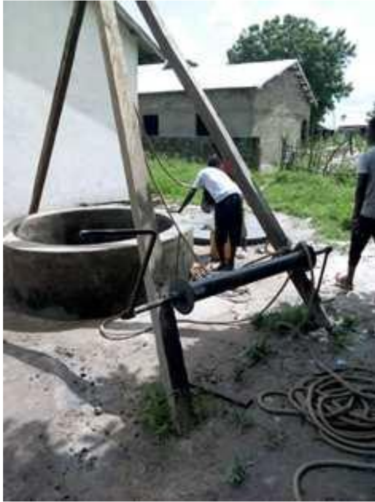
De Waterput wordt waterdicht gemaakt
