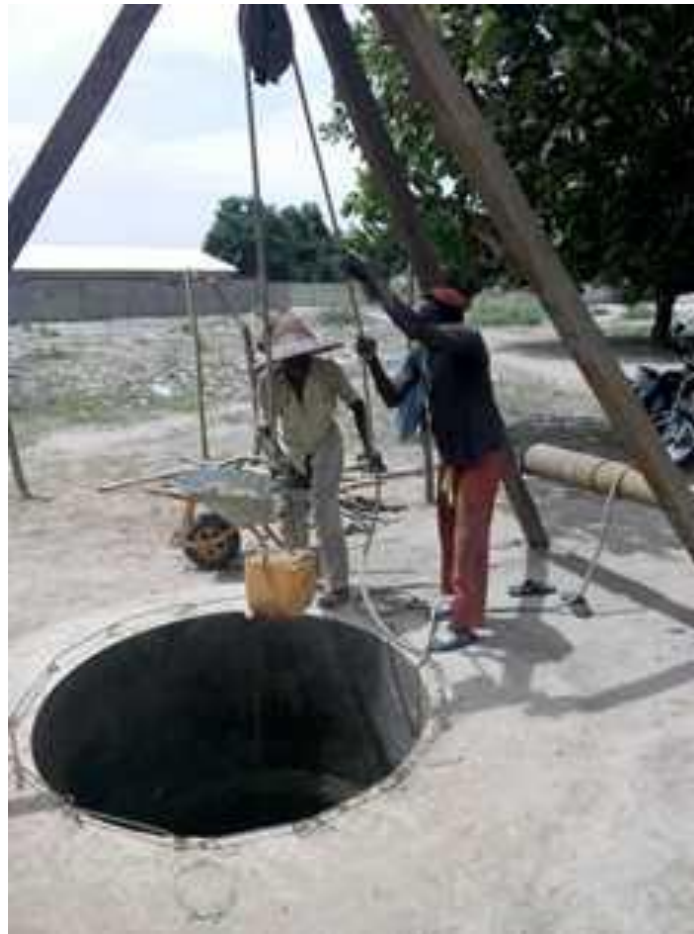
De put is 20meter diep en is opgebouwd met stalen ringen
